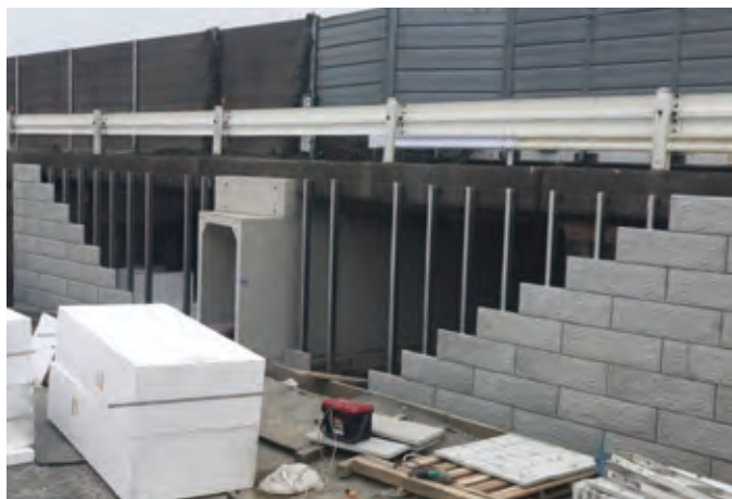
橋梁の土工化による耐震、延命化対策工事
